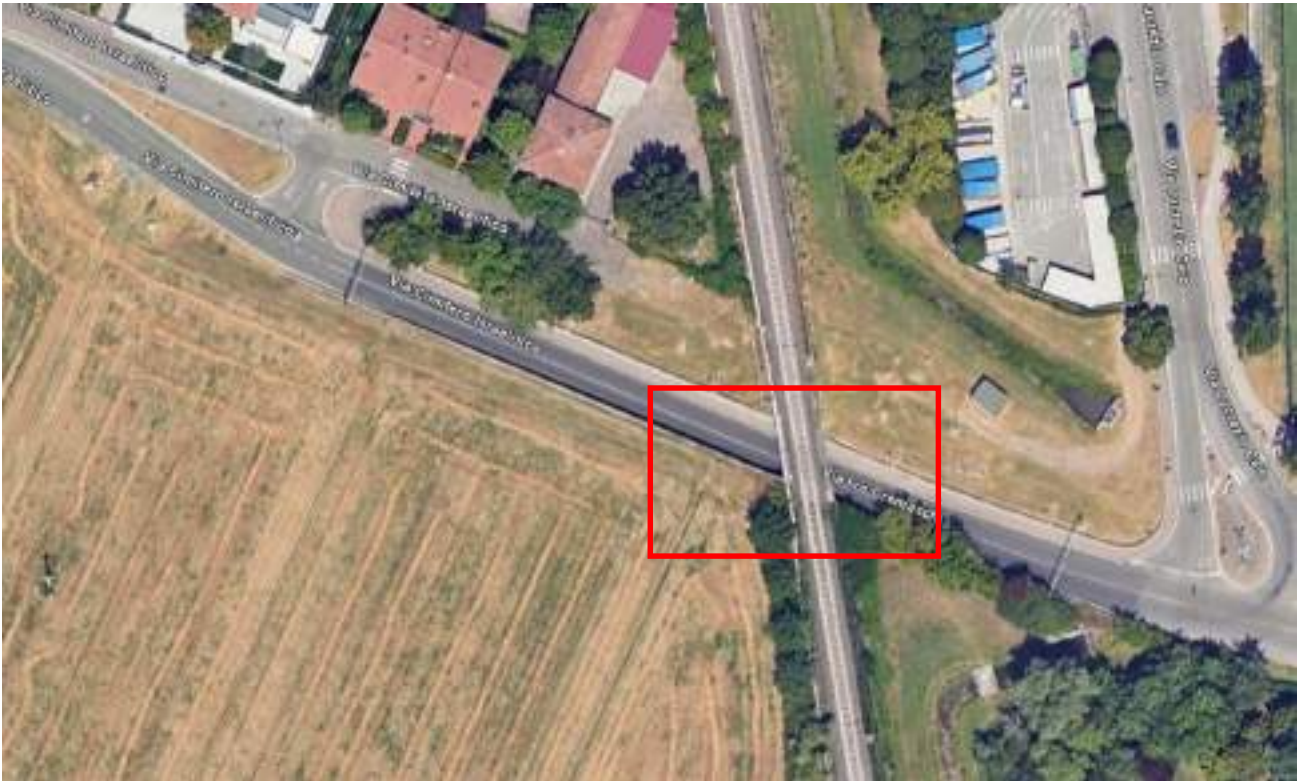
Foto aerea con individuazione del sottopasso di Via Cimitero Israelitico – Via Ivo Cremaschi
